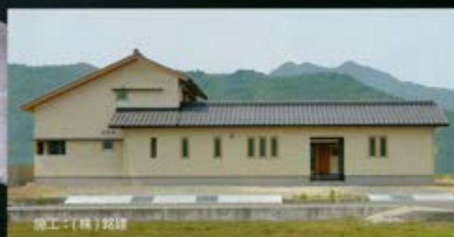
施工：(株) 西宮建設
